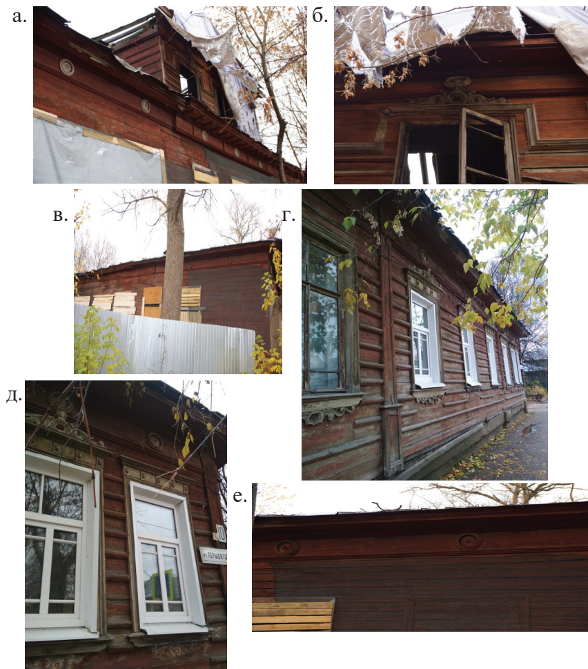
Рисунок 3. Усадьба А.Ф. Сумарокова. Фото 21.12.2021 (а. Разрушающийся мезонин дома; б. Окно мезонина и наличник; в. Боковой фасад с заколоченными проемами окон; г. Окна главного фасада: старое деревянное и новые пластиковые; д. Новые пластиковые окна главного фасада; е. Круглые розетки на фризе, утратившие белый цвет)
